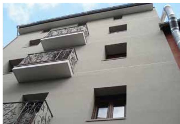
Reabilitação de edifício com Placotherm® V
